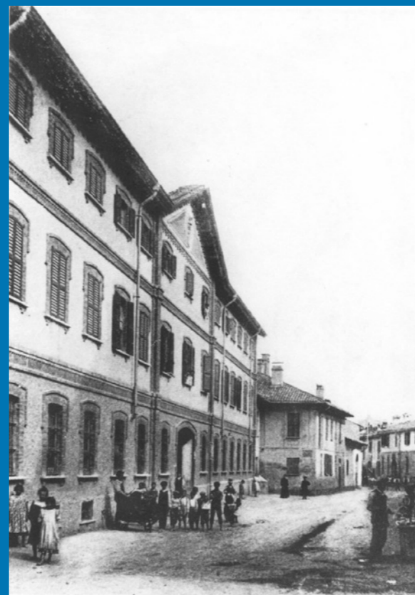
Via Umberto I (oggi via Cislaghi) nel primo 900.
